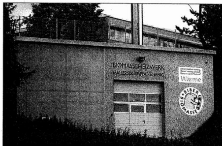
Das Biomasseheizwerk in Mallersdorf-Pfaffenberg von außen. □
